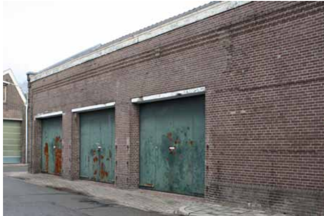
zuidgevel gebouw C
